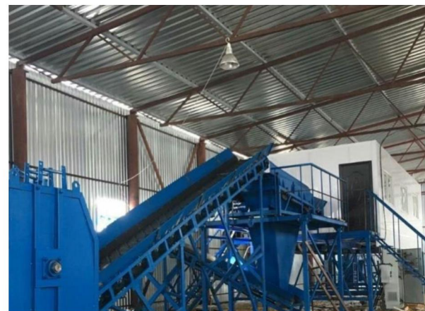
Грохот динамический с отводящим конвейером мелкой фракции (монтаж)
