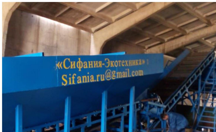
Бункер загрузочный (монтаж)
