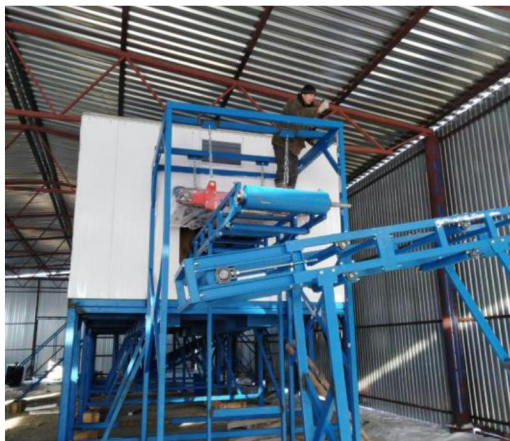
Металлосепаратор и конвейер остатка (монтаж)
