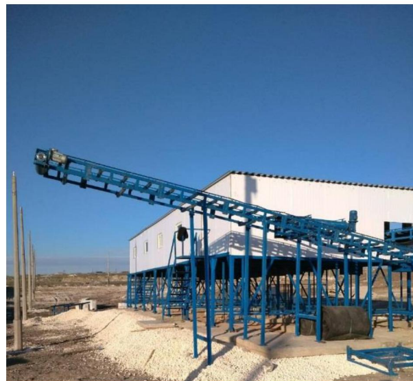
Конвейер остатка (монтаж)
