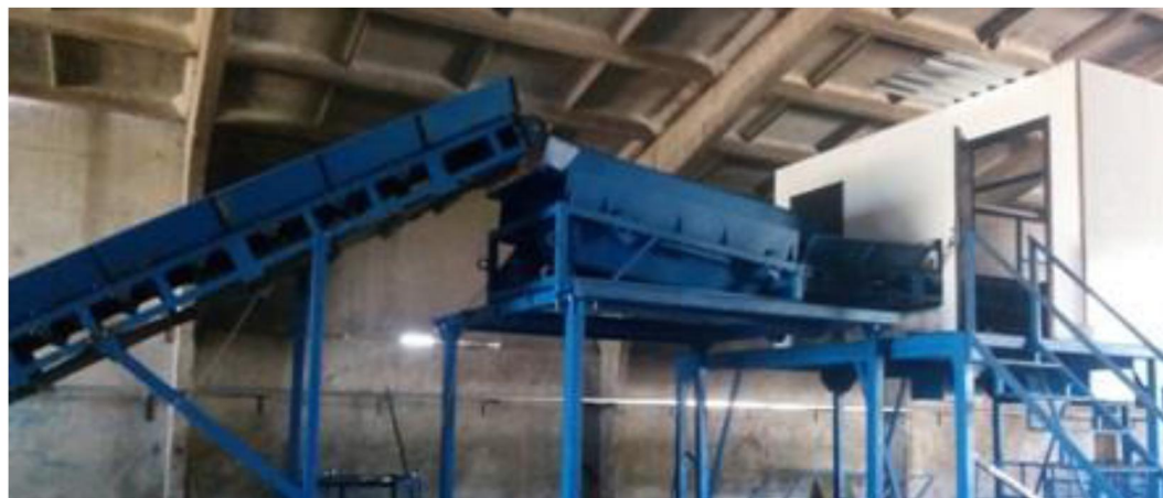
Грохот динамический (монтаж)
